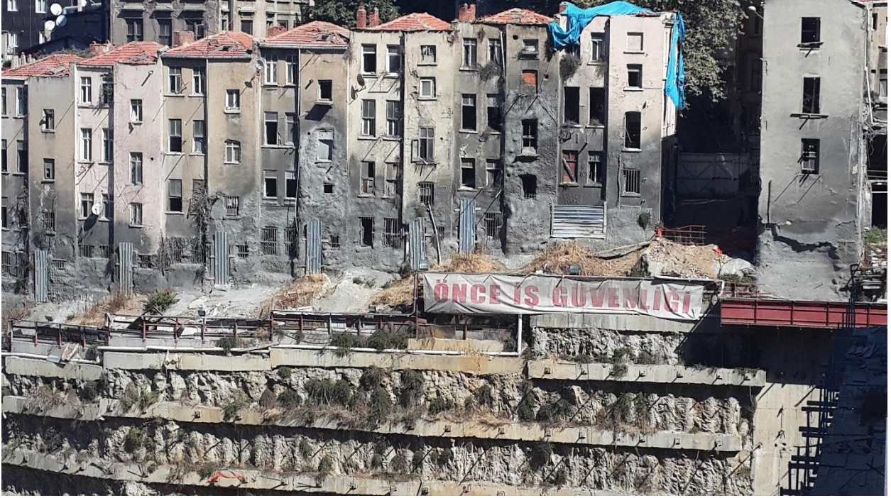
(Fig 5: Şişli’de yıkım çalışmaları)
